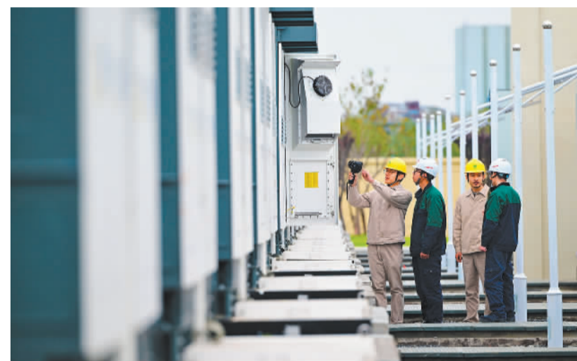
◀11月11日,四川华蓥市高兴储配煤基地正式运行,工人在接纳储配煤炭。 邱海鹰摄(中经视觉)
