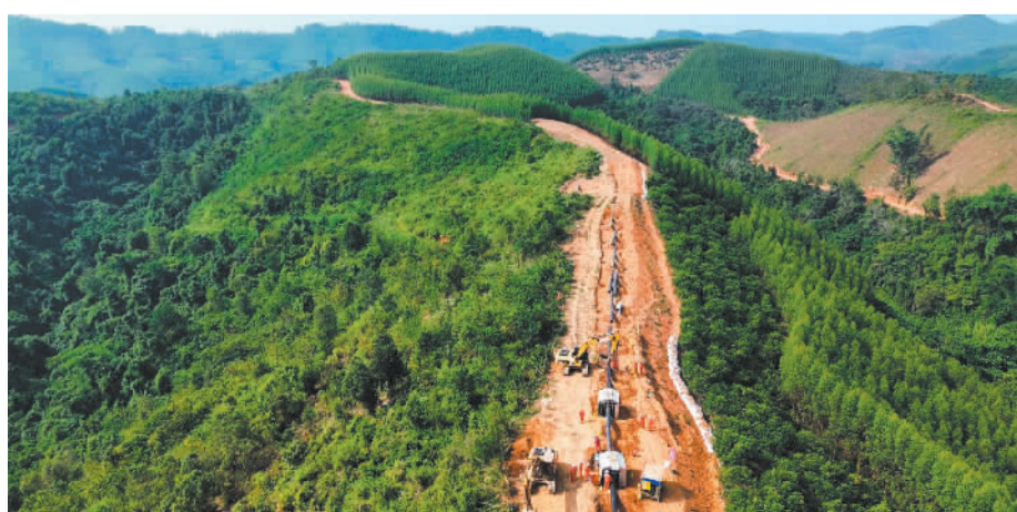
▼10月15日拍摄的位于云南文山富宁县的广西LNG外输管道复线(百色—文山)工程(云南段)施工现场。该工程线路全长约344公里,建成投产后将每年为滇东南地区增加10亿立方米天然气供应量。 黄 伟摄(中经视觉)
