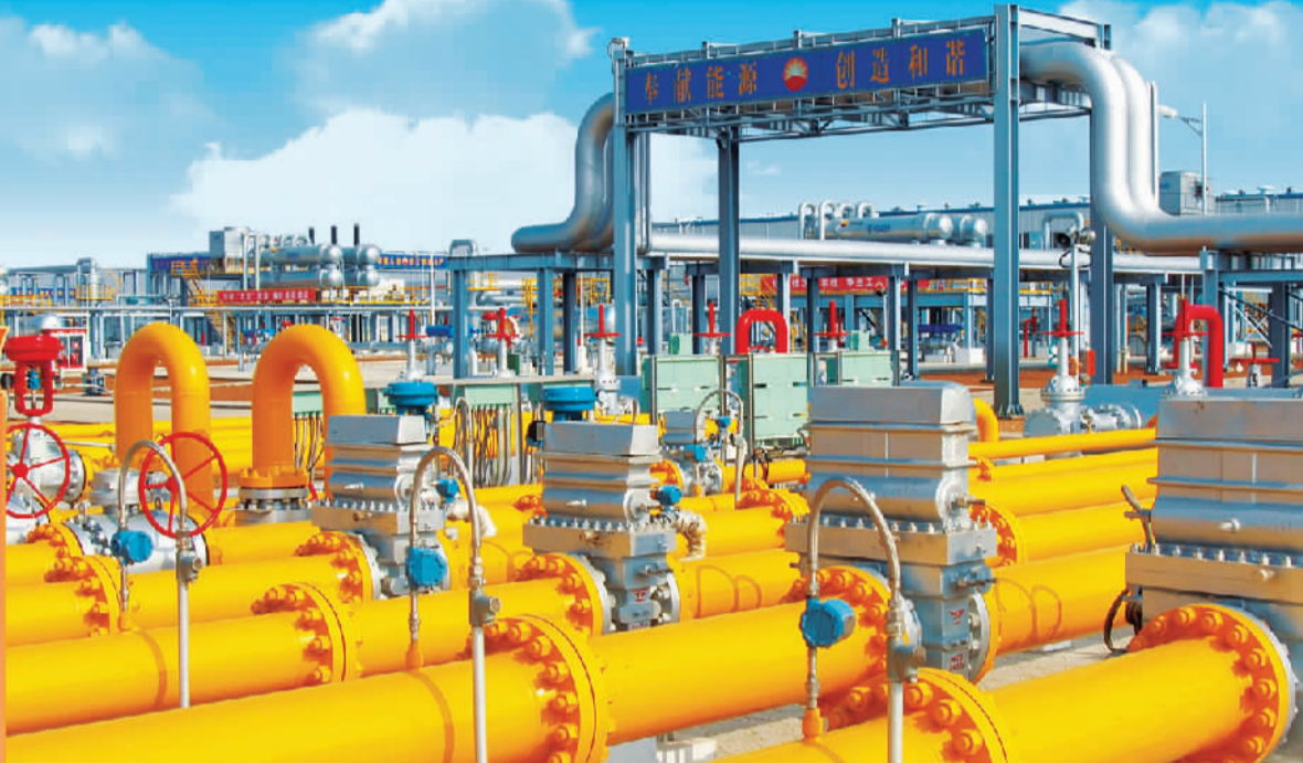
内蒙古鄂尔多斯市苏里格气田加紧生产，为陕京线及内蒙古周边地区做好能源保供。
