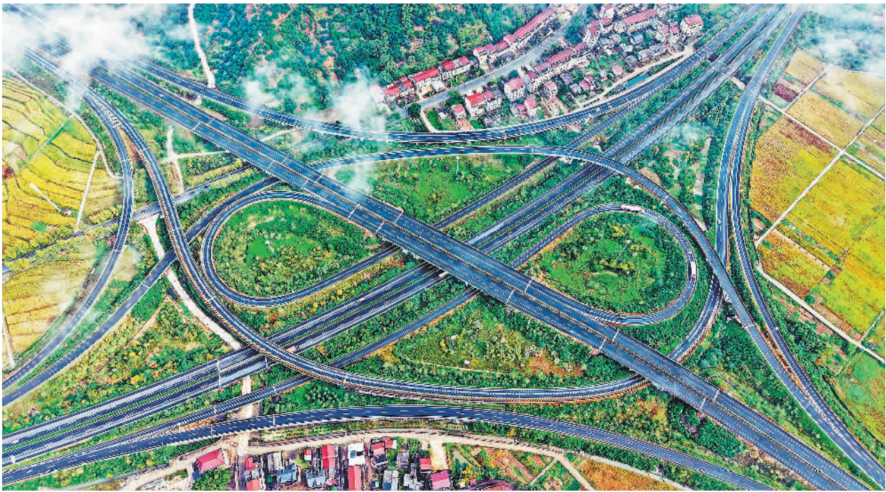
11月16日拍摄的浙江省临海市括苍镇高速公路。近年来,当地持续完善交通基础设施建设,不断优化城乡交通路网布局,助力经济社会高质量发展。 王华斌摄(中经视觉)
