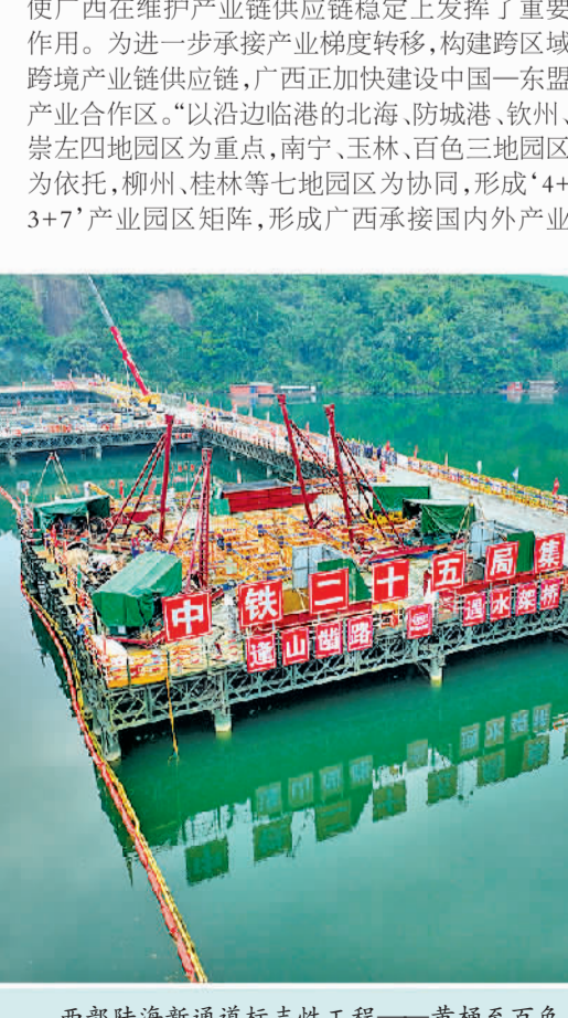
西部陆海新通道标志性工程——黄桶至百色铁路那蒙澄碧河特大桥施工现场。 冉锦涛摄
