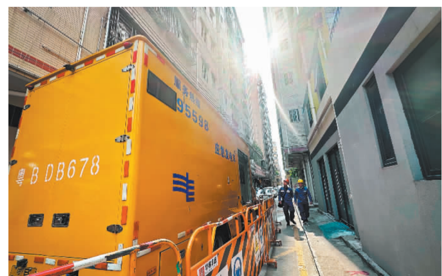
深圳市龙岗区大发埔村供用电安全专项整治现场
