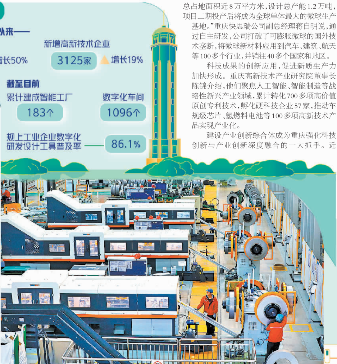
位于重庆长寿经开区的望变电气(集团)股份有限公司智能化铁芯工厂数字生产线。李辉摄
