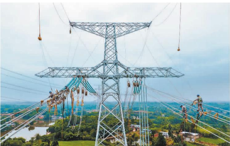
11月10日，四川省眉山市仁寿县，施工人员在高空作业。当日，金沙江上游—湖北±800千伏特高压直流输电工程（川中段）首个标段实现全线贯通。该项工程是目前世界上海拔最高的特高压直流输电工程，预计2025年建成投运，每年可向华中地区送电约400亿千瓦时。
