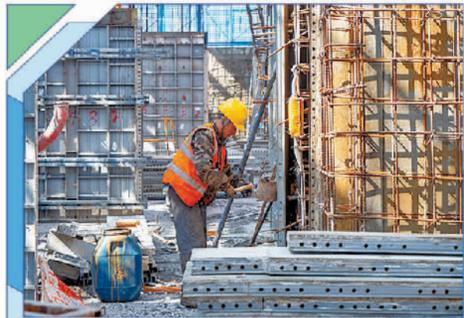
在位于江西南昌的中建三局江西金控数字金融创新产业园项目施工现场,施工人员在“住宅造楼机”作业平台施工。新华社记者 郭杰文摄
