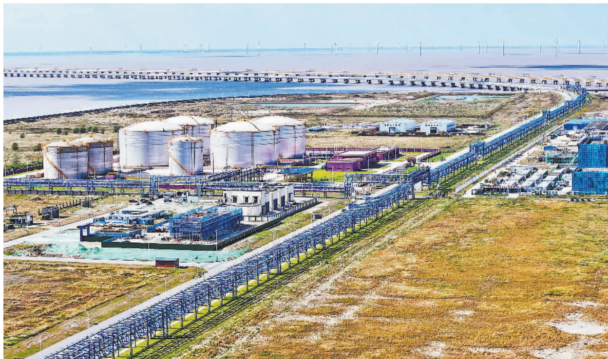
11月5日,江苏省首座海岛型变电站——如东县洋口港阳光岛110千伏输电项目完成跨海送电。该站投运后,可满足每年超过2000万吨的液化天然气(LNG)周转用能需求,更好助力长三角地区的能源绿色低碳转型和高质量发展。
