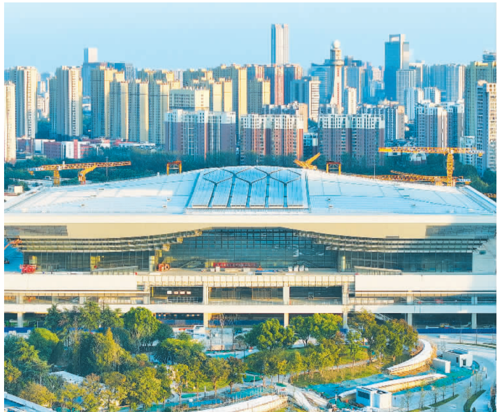
近日，位于安徽省合肥市蜀山区的新合肥西站项目现场塔吊林立，加快施工。据悉，该站是合肥铁路枢纽三大客站之一，车站总规模为8台18线，目前西侧站房主体已完工。
