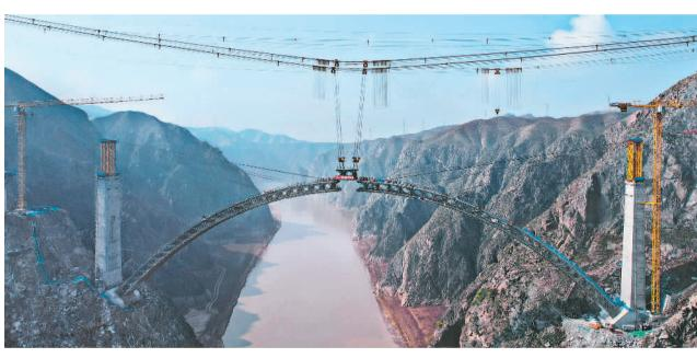
11月2日,由中铁第一勘察设计院集团有限公司设计、中国 铁建大桥局施工的兰合铁路洮河大桥主拱劲性骨架顺利合龙。 该大桥位于甘肃省临夏州永靖县与东乡县洮河峡谷区,是西北 地区最大跨度铁路钢筋混凝土拱桥。 范文博摄(中经视觉)
