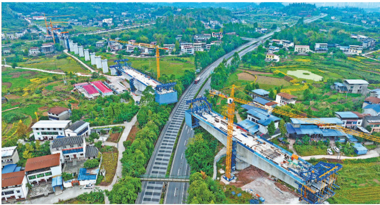
10月27日,西渝高铁康渝段站前十一标四川省广安华莹市清溪口特大桥建设现场。西渝高铁建成通车后,对促进成渝地区双城经济圈与关东平原城市群之间的联系,带动沿线地区经济社会发展具有重要意义。 张波摄(中经视觉)
