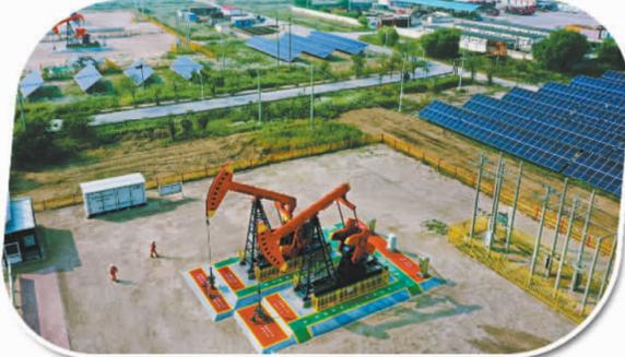
胜利油田依托分布式光伏电站构建形成智能微电网系统,为油井提供绿色供电
