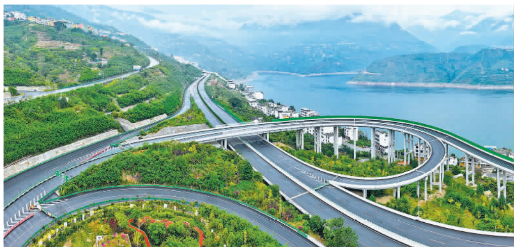
10月18日,云南省昭通市大关至永善高速公路上高桥至三合段正式开通运营,标志着大永高速全线正式通车。该高速是永善县第一条建成通车的高速公路,至此,昭通市实现县县通高速。
