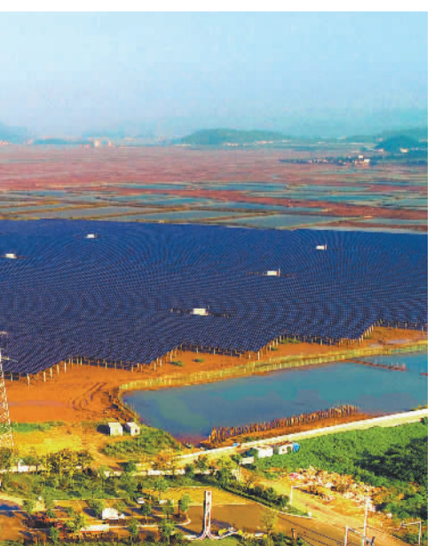
10月13日，在华南浙江玉环清港涂渔光互补光伏电站，约1800亩滩涂间带上，光伏设施向外输送清洁能源。近年来，当地依托丰富的光能风能资源，发展风力发电、光伏发电等，优化能源结构。吴达夫摄(中经视觉)
