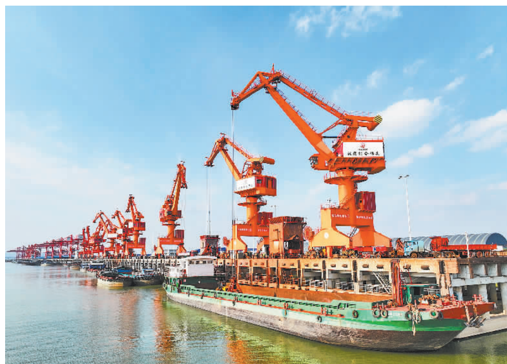
10月6日,位于江西省南昌市南昌县的姚湾综合码头,货船往来不绝,一派繁忙景象。近年来,南昌市大力发展码头水运事业,不断完善基础设施,提升物流效率。目前,姚湾综合码头逐渐成为重要的区域物流枢纽。(史港泽摄/中经视觉)
