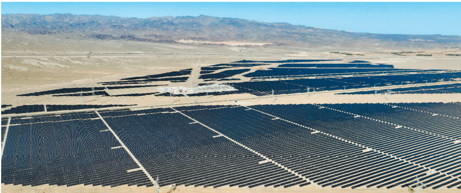
10月6日拍摄的甘肃省嘉峪关市戈壁光伏产业园。太阳能光伏电站矗立在茫茫戈壁，夜以继日“逐日”，让“光”变“电”，点亮千家万户灯火。 马玉福摄(中经视觉)
