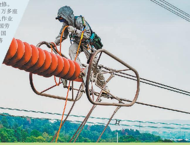
胡洪伟在40多米的高空，修复一处电线故障。
