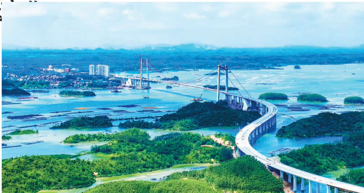
近日，航拍正在建设中的广西钦州市龙门大桥。龙门大桥是广西在建的最长跨海大桥，建成通车后，将打通广西滨海公路“卡点”，进一步促进当地经济社会发展。 林志摄
