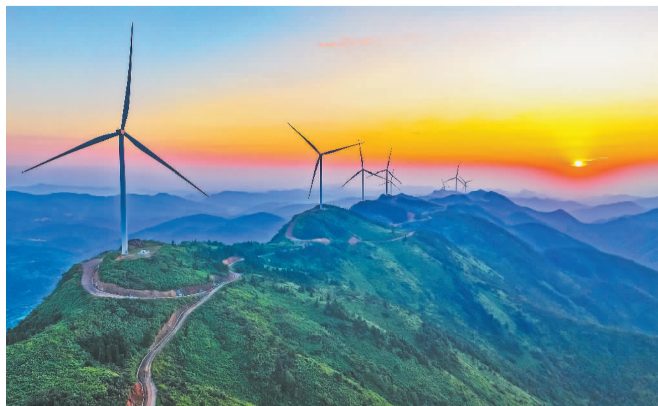
9月23日，江西省瑞昌市横立山风电场，一组成风电叶片矗立在群山之上。近年来，瑞昌市坚持绿色发展理念，利用高山风力资源优势，大力发展绿色清洁能源，实现经济效益与生态保护双赢。
