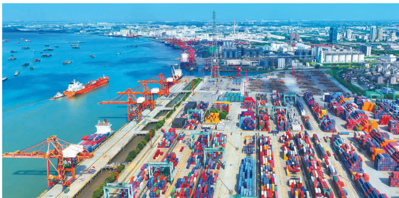
9月12日,江苏省张家港港口车船往来,作业繁忙。近年来,该港口全面推广岸电,让停靠船舶达到“零排放”,全力打造低碳港口,筑牢长江绿色生态屏障。
