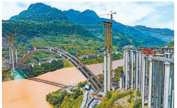
9月1日，位于四川省宜宾市屏山县的西宁河特大桥施工现场，施工人员进行抢抓工期。该大桥是宜攀高速（沿江高速）连接仁沐新高速的第一段路程，为西出川大通道四川沿江高速控制性工程之一。吴鑫摄（中经视觉）
