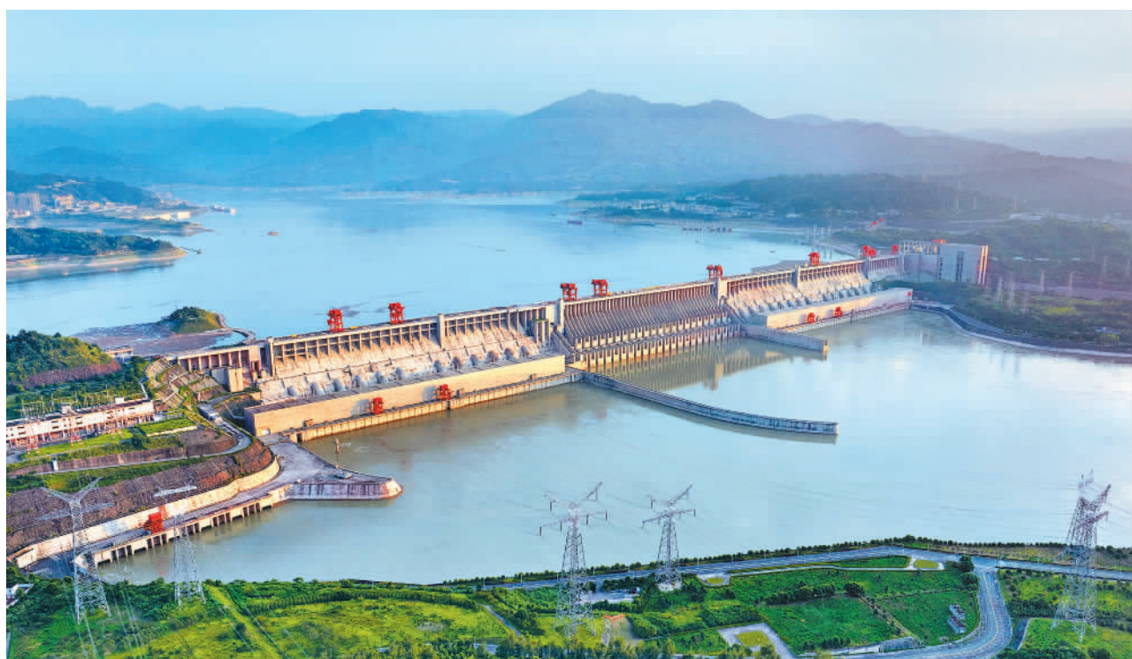
8月13日，俯瞰三峡大坝全景及三峡电站的输电设施。乌东德、白鹤滩、溪洛渡、向家坝、三峡、葛洲坝6座梯级电站，共同构成了世界上最大的清洁能源走廊，高峰出力超7000万千瓦。
