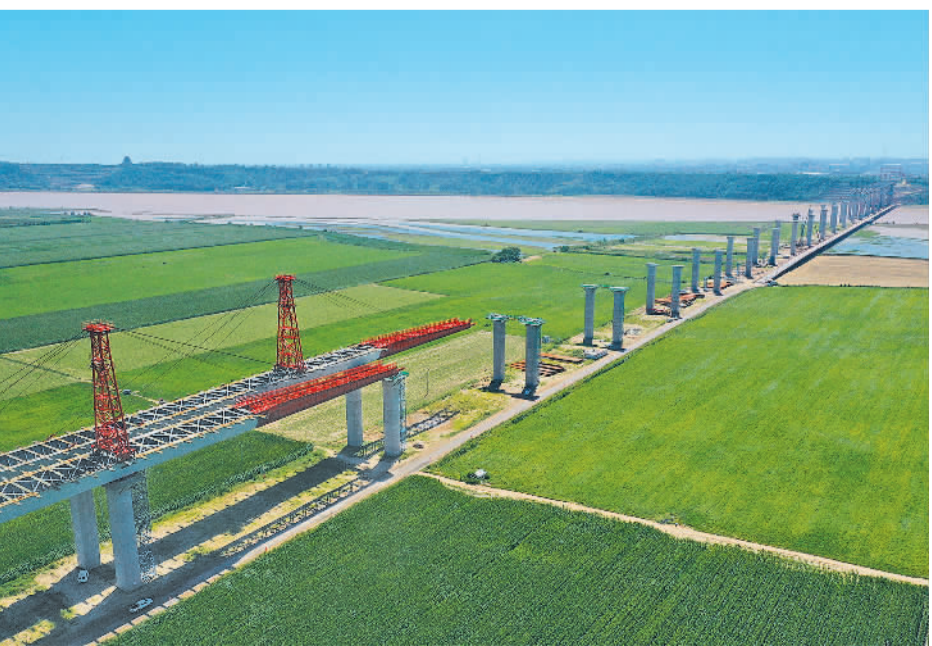
8月12日,河南省焦作市温县境内的焦平高速焦梁段黄河特大桥正加紧施工。该项目是河南省高速公路重点项目之一,建成后连接嵩山、云台山、陈家沟等多个旅游资源,对带动沿线发展具有重要意义。徐宏星摄(中经视觉)
