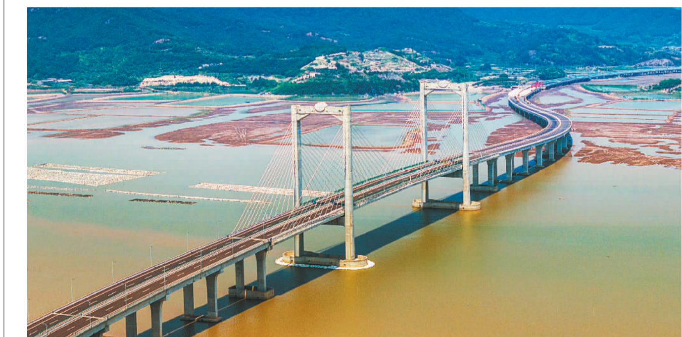
位于浙江省宁波市宁海县境内的旗门港大桥项目正在紧张建设中。大桥建成后,将大大缩短宁波宁海到台州三门之间的距离,带动两地经济社会发展。 胡学军摄(中经视觉)
