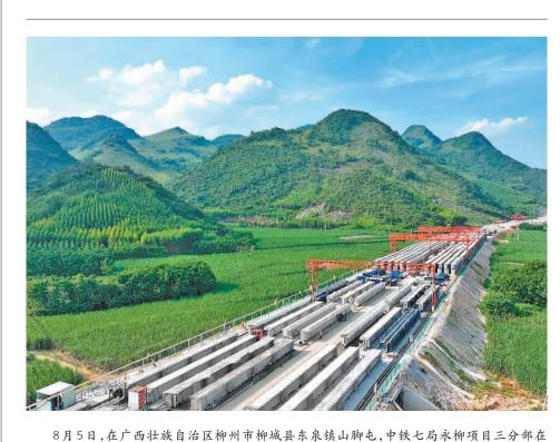
6月5日,在广西在族自治区柳州市柳城县东永镇山湖屯,中铁七局水柳项目三分部在运梁现场作业。当日,该项目4个分部全面进入架梁施工作业阶段,为工程项目整体建设按下"快进键"。永柳高速公路的建设将进一步完善广西高速公路网及泛珠三角区域路网,对推动区域经济发展、带动沿线产业发展具有重要意义。 黎寒池摄(中经视觉)
