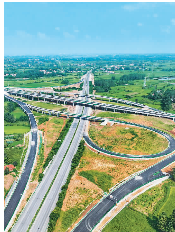
8月7日,湖北襄南高速项目的关键控制性工程方家集枢纽互通施工进入收尾阶段。该项目是湖北省“十四五”交通建设重点项目,建成后将进一步完善襄阳高速公路网。 谢勇摄(中经视觉)
