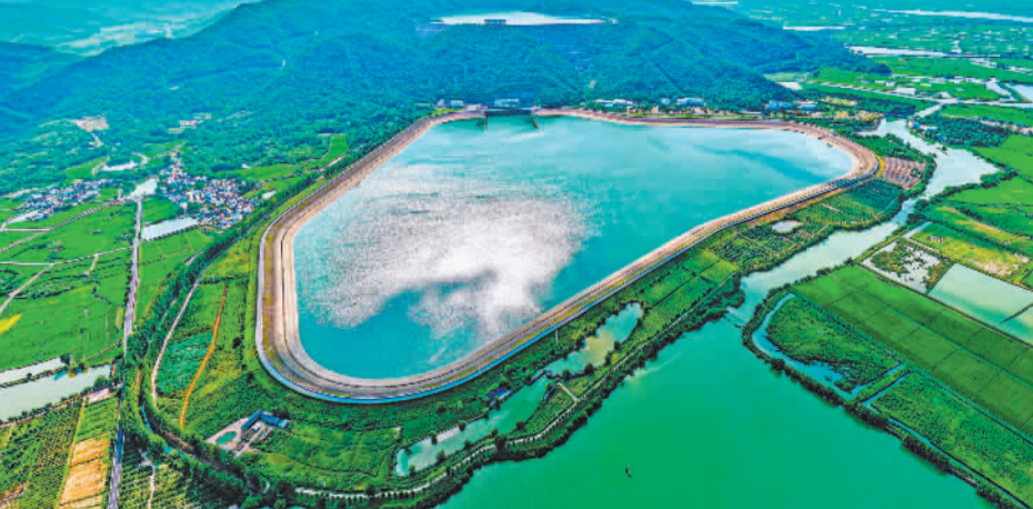
8月3日，航拍安徽芜湖响水涧抽水蓄能电站。该电站总装机容量100万千瓦，设计年发电量17.62亿千瓦时，主要承担电力系统调峰、填谷、调频等多种功能，对保障华东电网的安全运行具有重要意义。潘柳全摄(中经视觉)
