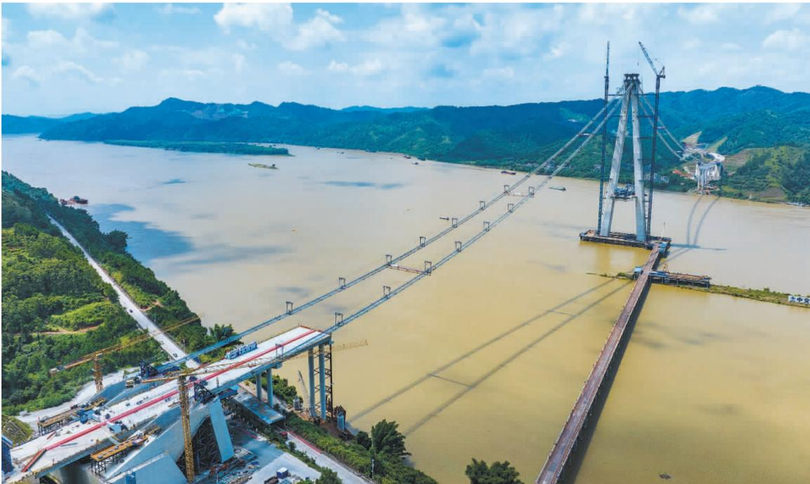
8月6日，位于广西梧州市藤县滨江镇的平(南)岑(溪)高速公路藤州江特大桥正加紧施工。目前大桥主塔已经封顶，计划于今年底建成通车。
