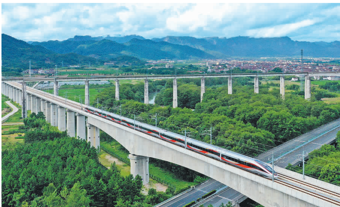
运行阶段线路。7月26日，从桐庐东站出发。当日，新建杭温高铁正式开通运营。
