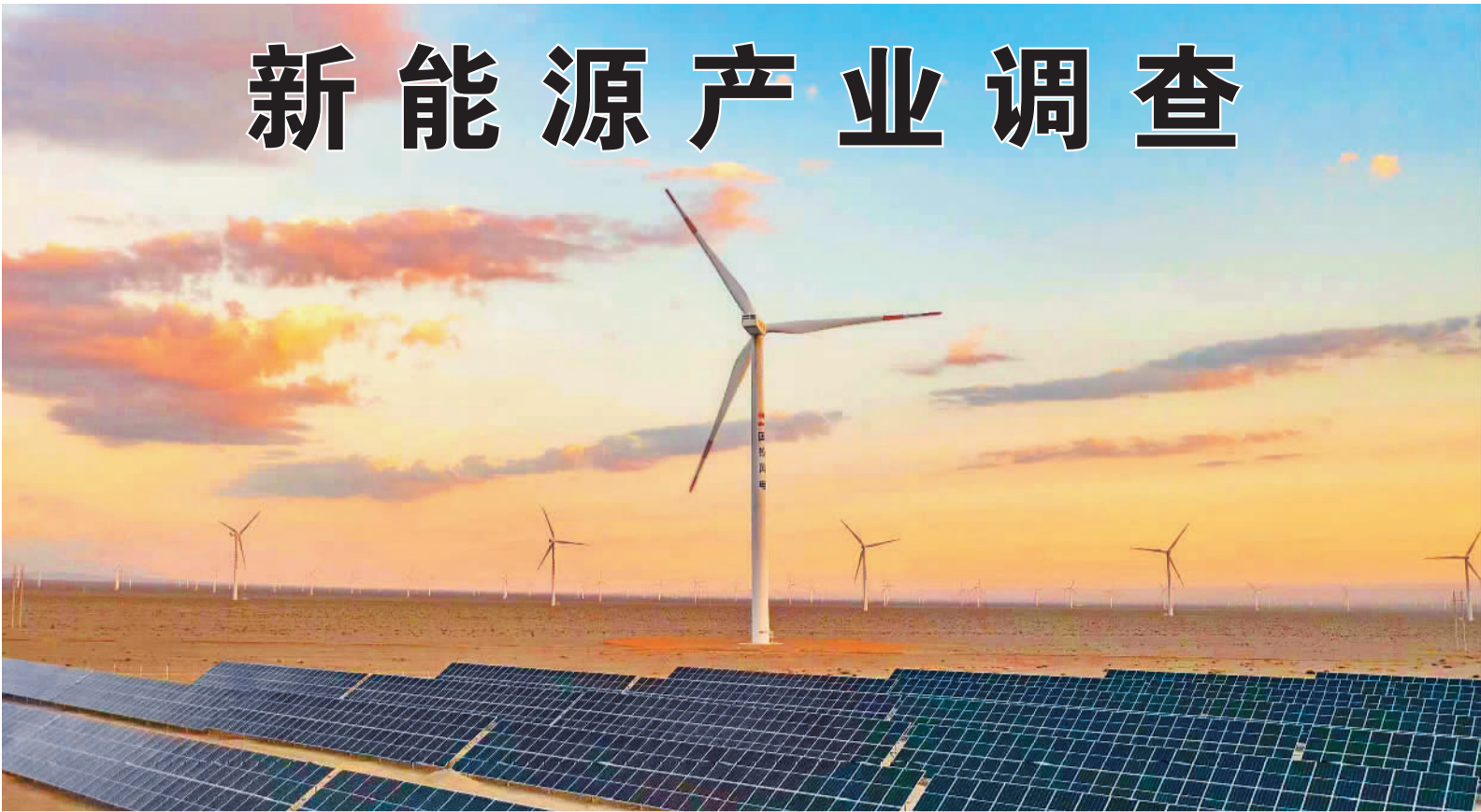
国投新疆新能源伊吾光伏+储能项目。
