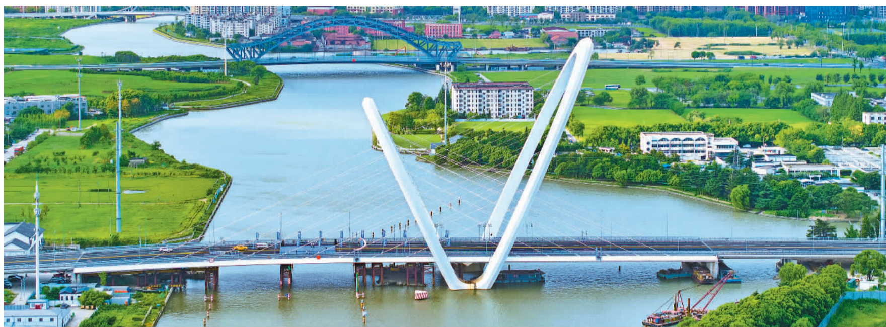
7月26日，江苏省昆山市中张线青阳港段航道整治工程黄川桥正式通车。该桥通车后，不仅提升了青阳港航道的通航能力，还打通了昆山“入江达海”的内河集装箱运输通道，为昆山与周边海港的直达联系提供了便利。 袁新宇摄（中经视觉）
