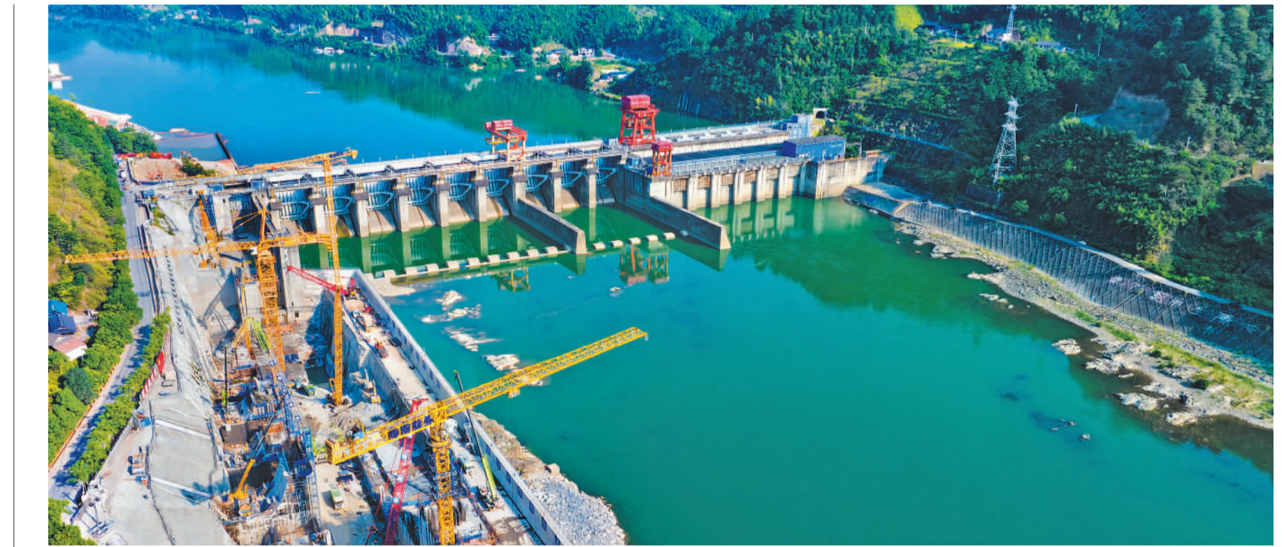
7月26日，沅水洪江至辰溪航道建设工程上建二标工地，工程建设者正在进行船闸主体施工。项目建成后，将进一步补齐湖南省水运基础设施短板，更好服务沿江产业布局。
