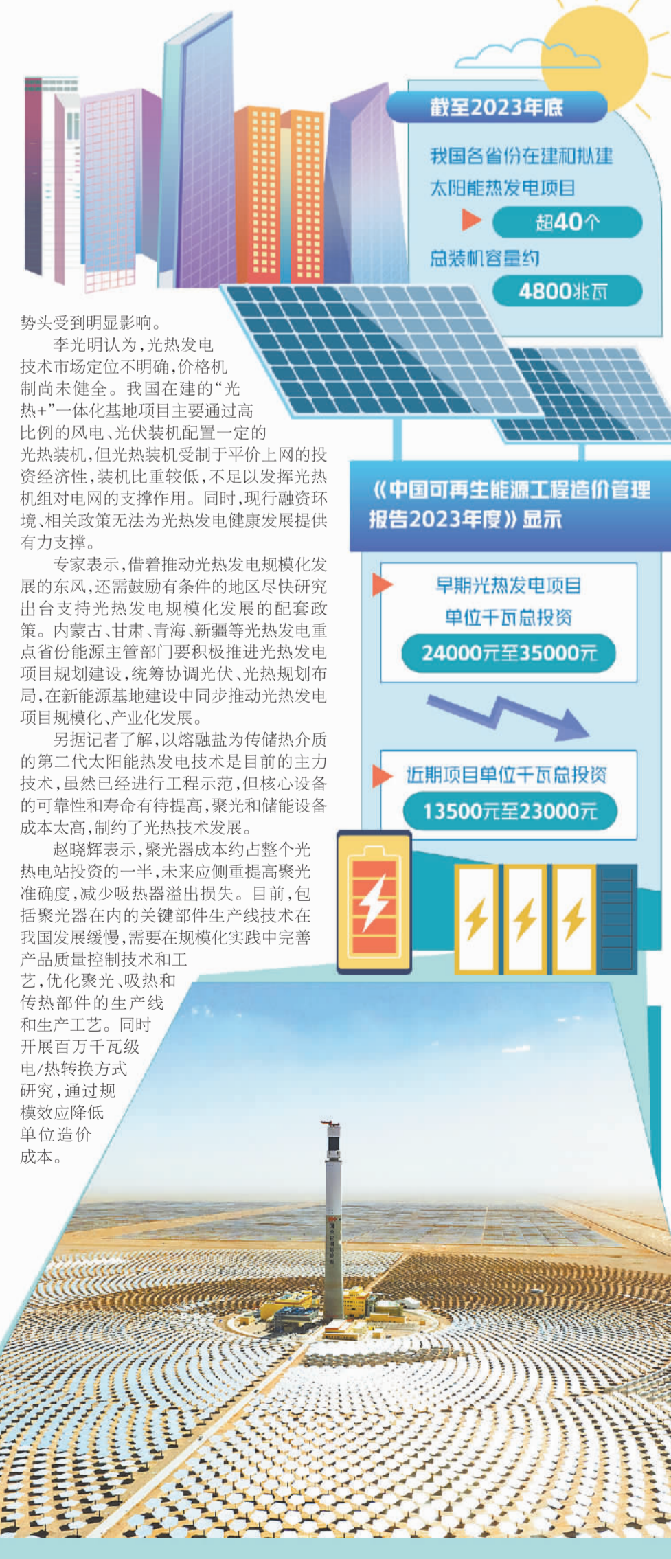
甘肃省酒泉市阿克塞县东新能源光热+光伏示范项目。该项目总体装机容量 750 兆瓦，其中光热发电 110 兆瓦，光伏发电 640 兆瓦。 金伟摄（新华社发）
