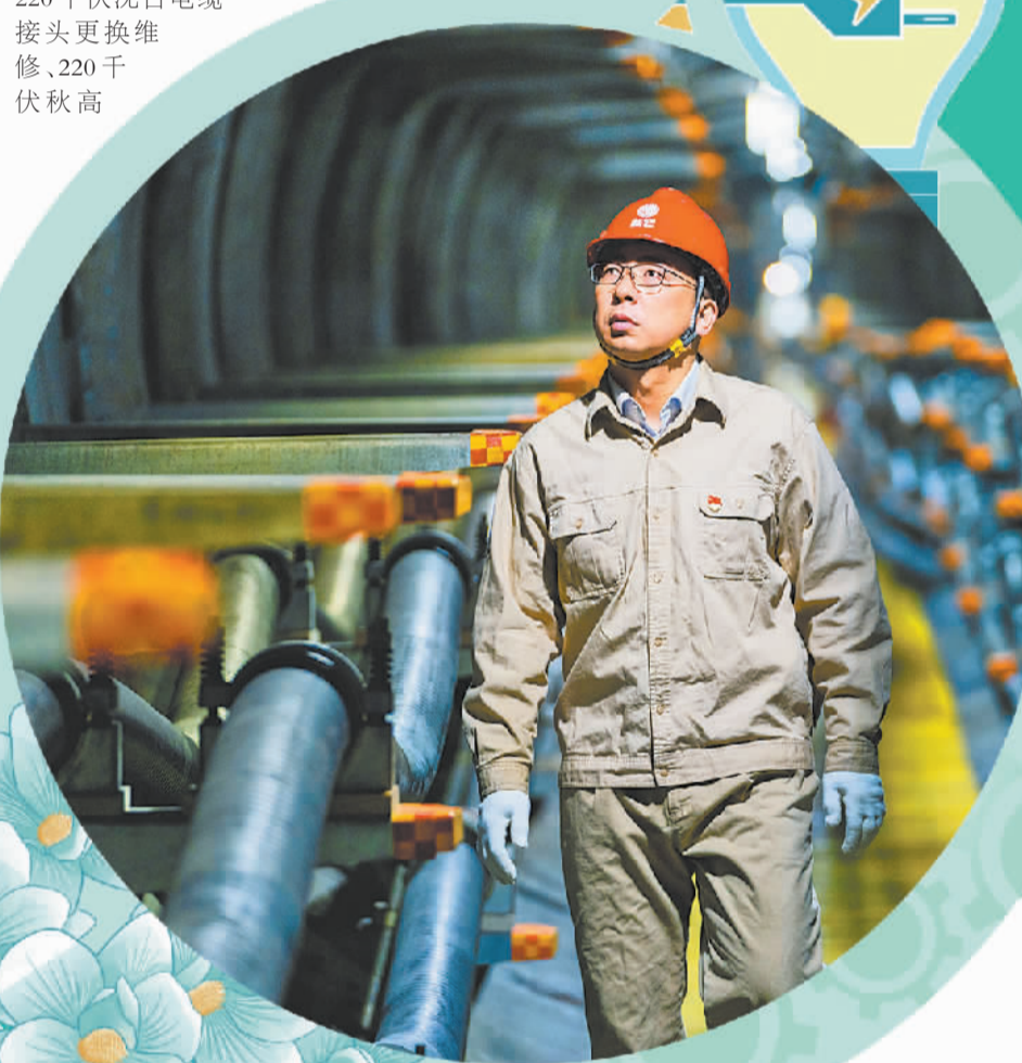
吕立翔在对220千伏宁莫线电缆隧道开展巡检。 杜 懿摄(中经视觉)
