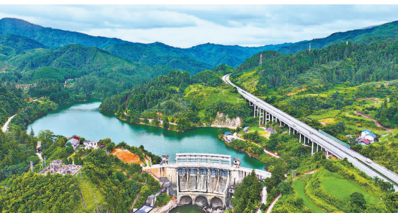
7月19日，位于贵州省锦屏县大同乡的八河水电站周围山清水秀，景色宜人。近年来，当地凭借丰富的水能资源，大力发展水力发电，推动绿色能源转型，实现生态效益和经济效益双赢。
