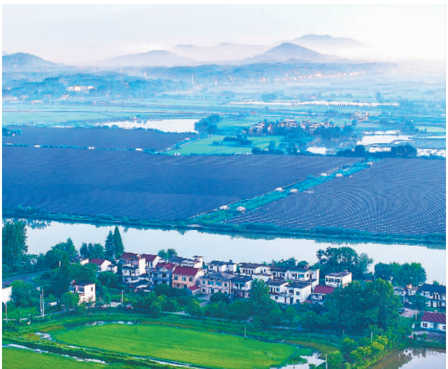
7月16日，在安徽省芜湖市繁昌区平铺镇新塘村，渔光互补光伏电站熠熠生辉。近年来，繁昌区依托当地水乡地理优势，聚焦绿色低碳转型发展，将光伏发电和渔业养殖相结合，形成“水上发电、水下养殖”的绿色养殖模式，实现生态效益、经济效益双丰收。 鲁君元摄（中经视觉）
