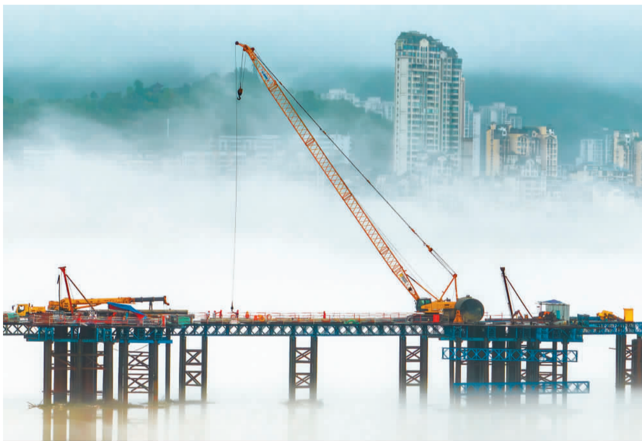
7月12日,重庆市开州区汉丰湖云雾缭绕,工人正在修建滨湖栈道。近年来,开州区持续优化环湖城区配套设施,加快推进滨湖栈道、步道等景观建设,满足市民休闲需求、改善人居环境、提升城市品质。 王晓宇摄(中经视觉)
