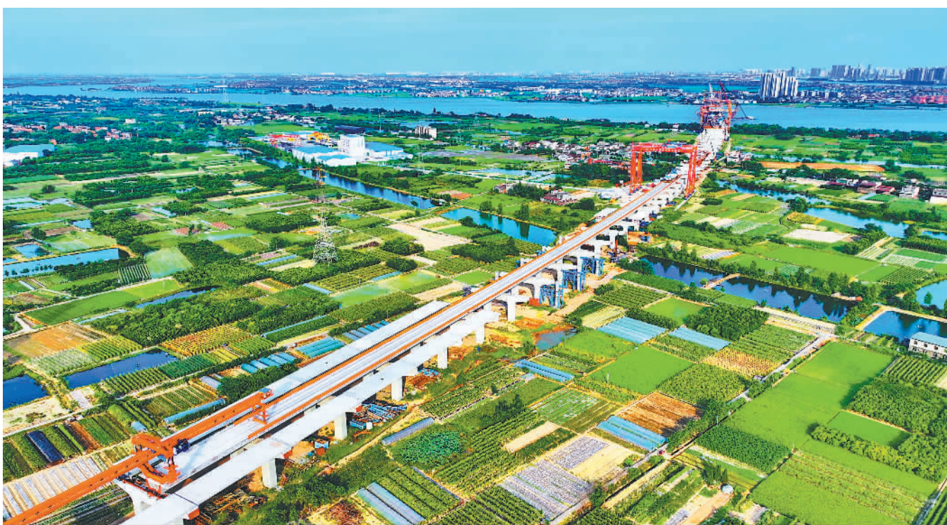
7月8日,位于江西省南昌市东湖区扬子洲镇的昌九高铁南昌扬子洲赣江公铁大桥建设现场,工人正在加紧施工作业。
