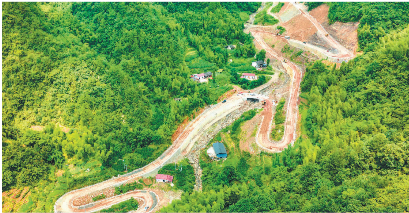
7月2日,重庆市开州区和谦镇双河村旅游公路建设现场,工人们正在施工。该旅游公路全长24公里,同步完善安防设施、观景台、充电桩等附属设施,预计年底建成通车,将有效推动乡村文旅融合发展。王瑞宇摄(中经视觉)
