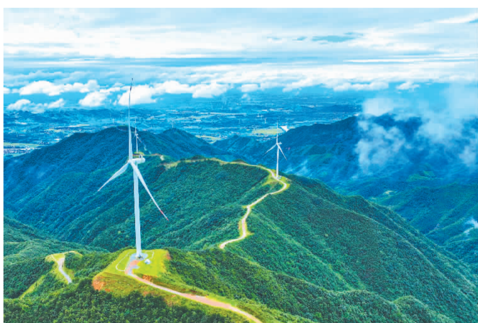
7月2日,湖南省永州市道县井塘风电场,风电机组在云雾中随风转动,源源不断地输送着绿色能源。近年来,道县大力推进风电新能源项目建设,促进区域经济发展和生态环境保护。蒋克青摄(中经视觉)
