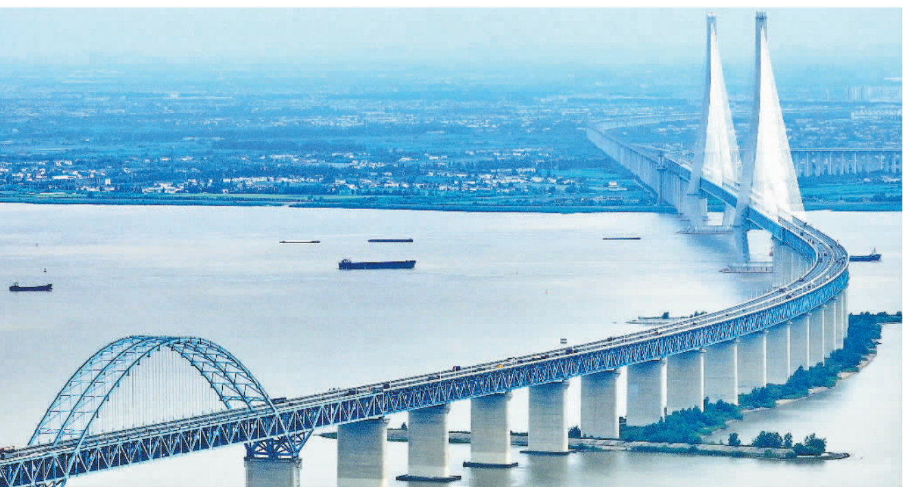
7月1日在江苏南通拍摄的沪苏通铁路跨长江控制性工程沪苏通长江公铁大桥。
