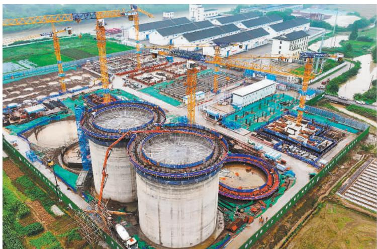
7月1日,江苏省太仓市储备粮管理有限公司新建粮食储备用房及配套用房项目现场,工人正在进行圆仓、配套工作室等项目载体施工。该项目总建筑面积约19500平方米,规划总仓容8.5万吨,预计明年年初竣工。 计海新摄(中经视觉)
