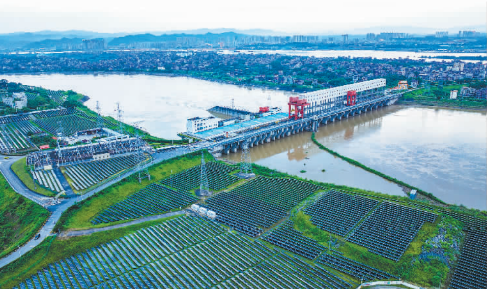
6月26日,广西梧州市长洲水利枢纽水电站和光伏电站正在运行。长洲水利枢纽光伏电站采取水电、光伏互补的模式运作,可有效促进生态经济和清洁能源产业发展。
