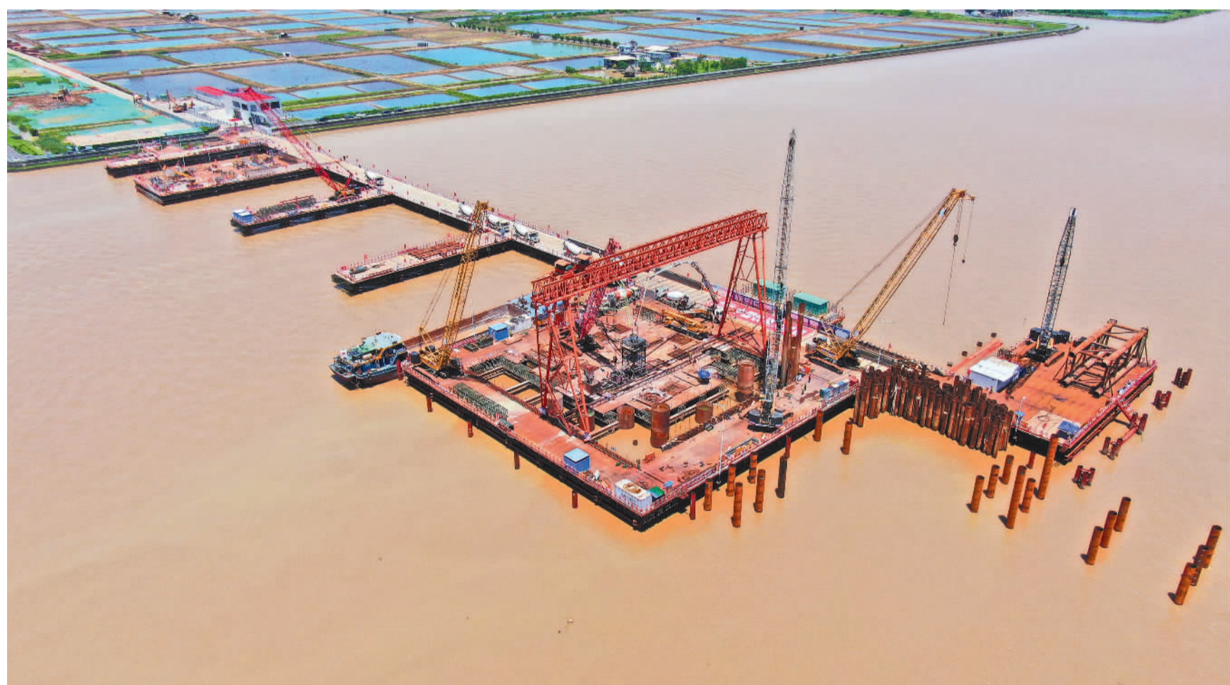
6月21日,由中铁建大桥局施工的世界最大跨度自锚式悬索桥——万龙大桥主墩桩基施工全部完成,工程将进入水上施工阶段。大桥作为广州南沙南部组团路网的关键一环,建成后将强化南沙港货运集散功能,提高对外辐射能力,助力粤港澳大湾区高质量发展。赵泽银摄(中经视觉)
