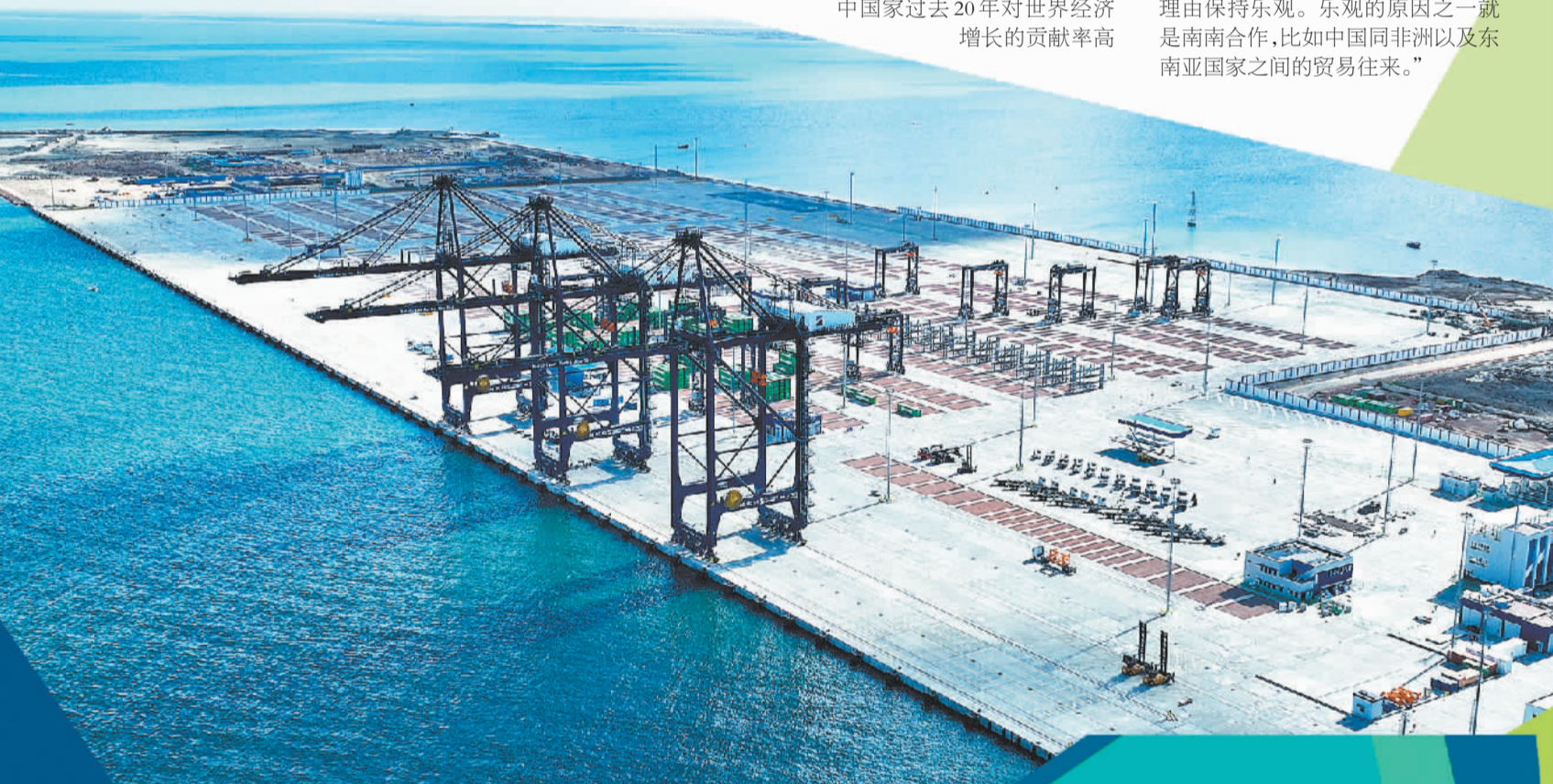
在埃及亚历山大,由中国港湾工程有限责任公司承建的阿布基尔集装箱码头正式运营。 (新华社发)
