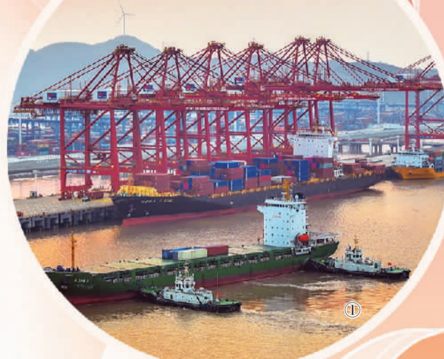
图① 浙江宁波舟山港金塘港区码头作业繁忙。姚峰摄(新华社发)
