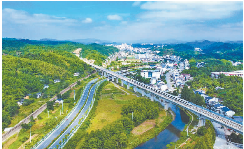
6月13日，安徽省黄山市祁门县，畅通的路网在青山绿水映衬下成为一道亮丽的风景线。近年来，祁门县加大交通基础设施建设，围绕“生态、添彩、增色”的建设思路，实现路旁是景，景中有路，在有力改善群众出行条件的同时，也为当地旅游业发展带来机遇。(程启群摄(中经视觉))
