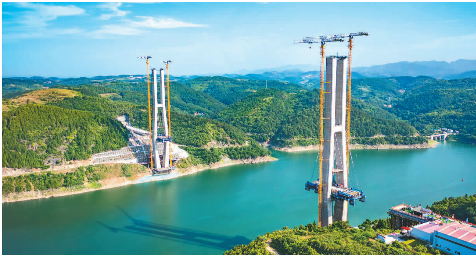
6月14日,湖北省十堰市郧阳区西十高铁汉江特大桥项目进入主梁施工阶段。为应对持续高温天气,中铁十一局项目部采取多种防暑降温措施,并确保施工安全。
