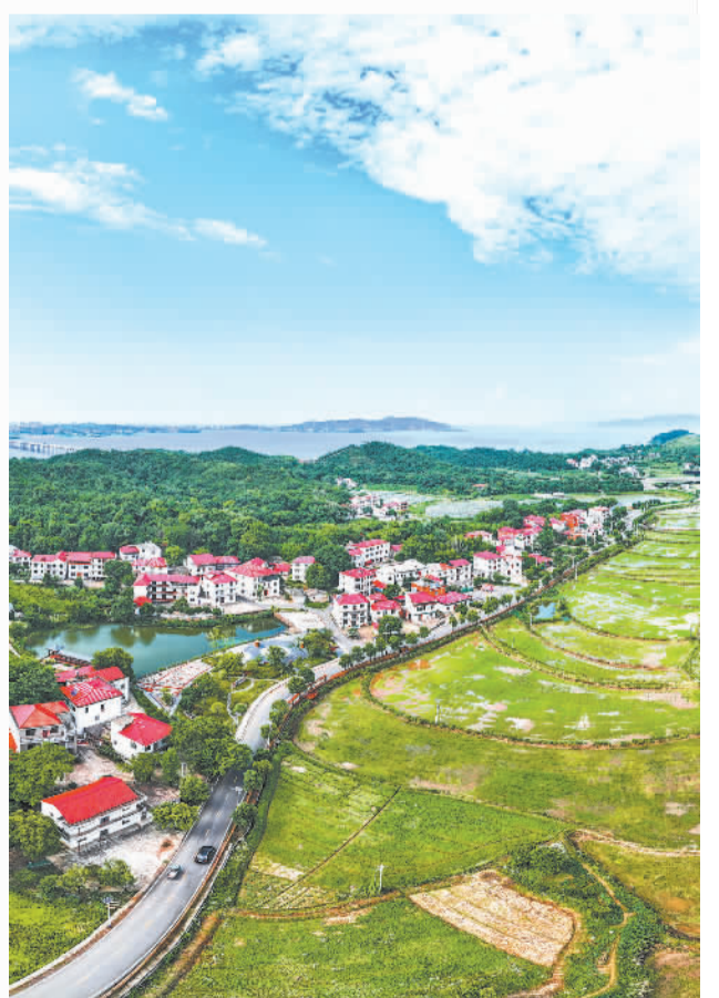
6月12日,江西省九江市濂溪区虞家河乡开天村,双车道沥青路穿村而过。濂溪区近年来大力实施县道升级改造等工程,不断改善的交通环境成为当地发展助推器。
