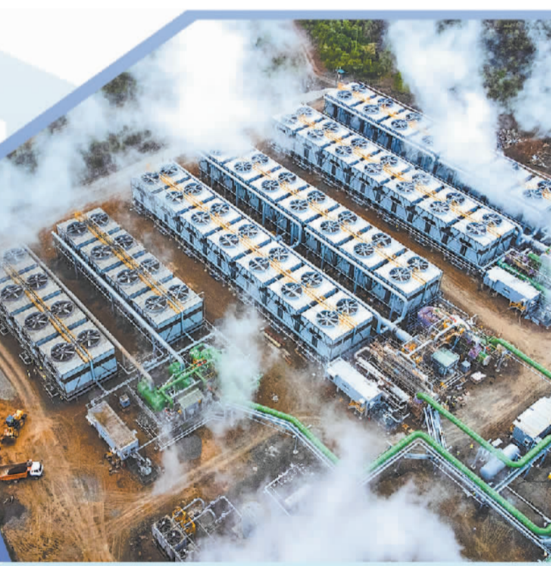
图为位于肯尼亚纳库鲁市，由中企承建的索西安地热能电站项目建设现场。新华社记者 王冠森摄
